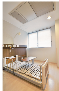
無菌室 5つの個室では天井にHEPAフィルターを設置しております。免疫力の落ちた患者さまの空気感染を予防します。
